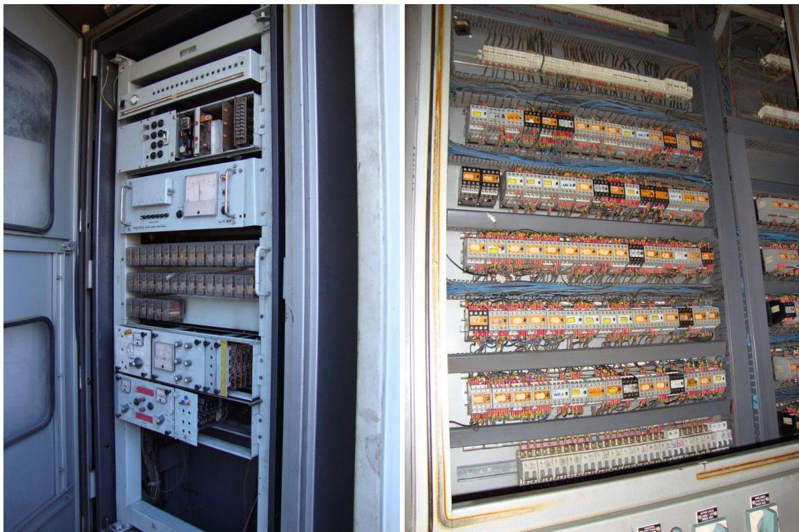
Obr. 5a,b: Původní vybavení stanice magistrálního dopravníku TC lignitu MT-2. Fotografie pořízeny během návštěvy lokality.
